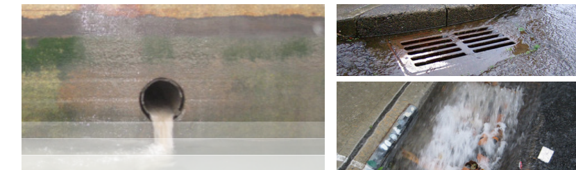
Em baixo, à esquerda: transbordamento de um esgoto combinado é liberado num fluvial local em Nova Jersey; à direita: em cima, águas pluviais correm para uma tempestade da valeta e inferior inundações
